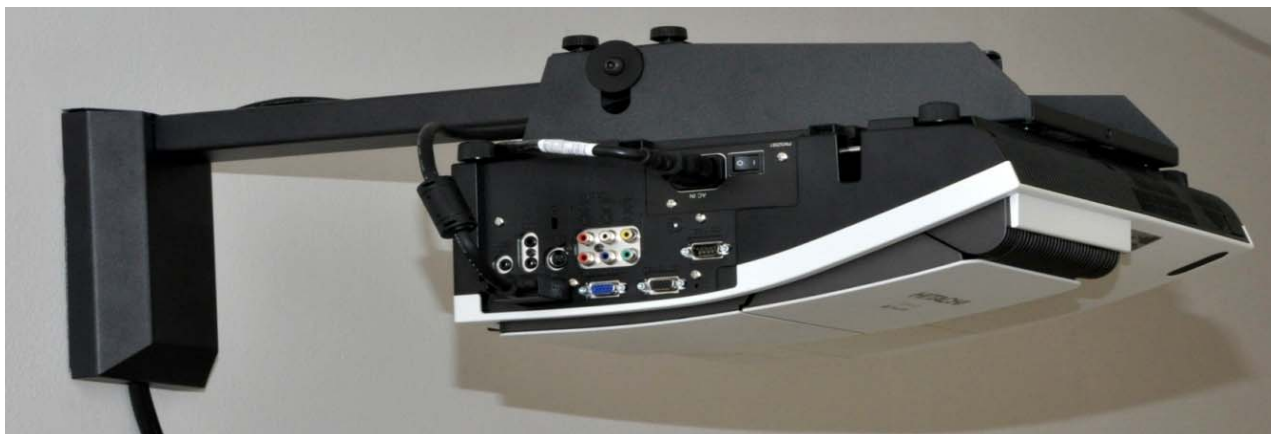
Inštalácia projektora na nástennom ramene
